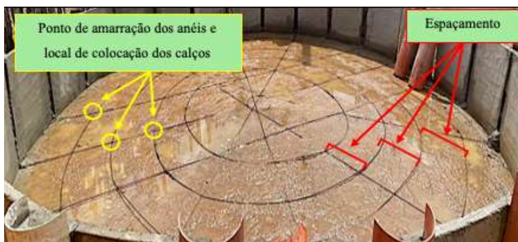
Figura 8. Ferragem do fundo do tanque (Fonte: acervo pessoal do autor).
