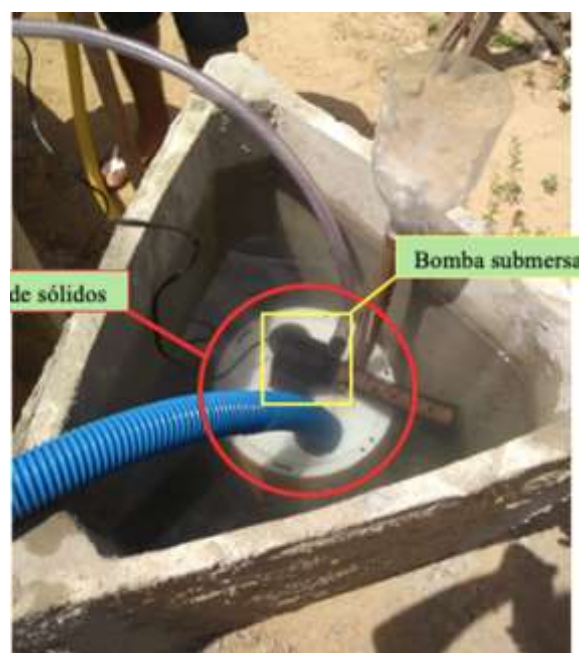
Figura 14. Filtro de sólidos e bomba submersa instalados adequadamente dentro do sedimentador (Fonte: acervo pessoal do autor).
