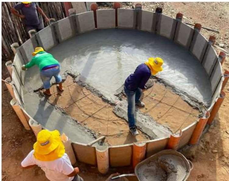
Figura 6. Detalhe da ferragem de fundo e concretagem inicial do piso do tanque. (Fonte: Acervo do Autor, 2020).
