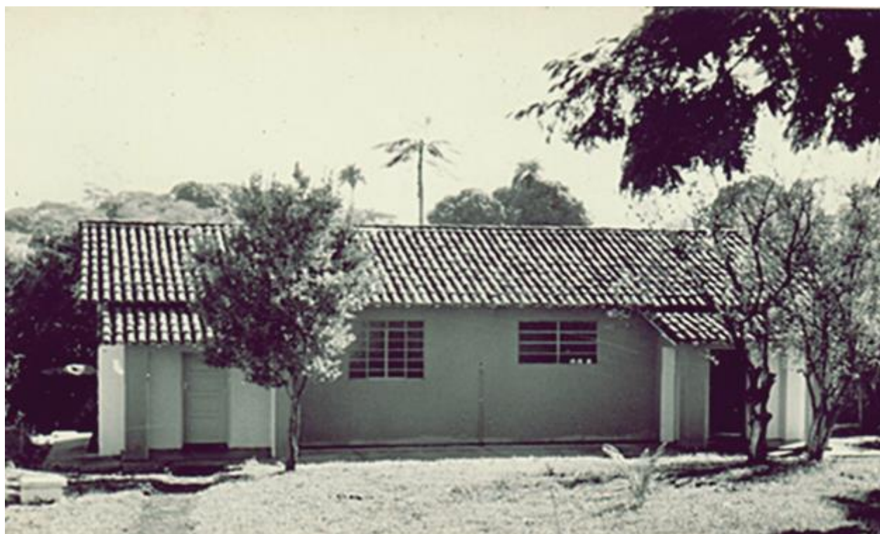
Figura 1. Casas geminadas destinadas para instalação do Laboratório de Piscicultura, à jusante da Represa Risca Faca, Campus da USP Fernando Costa, Pirassununga, estado de São Paulo.
