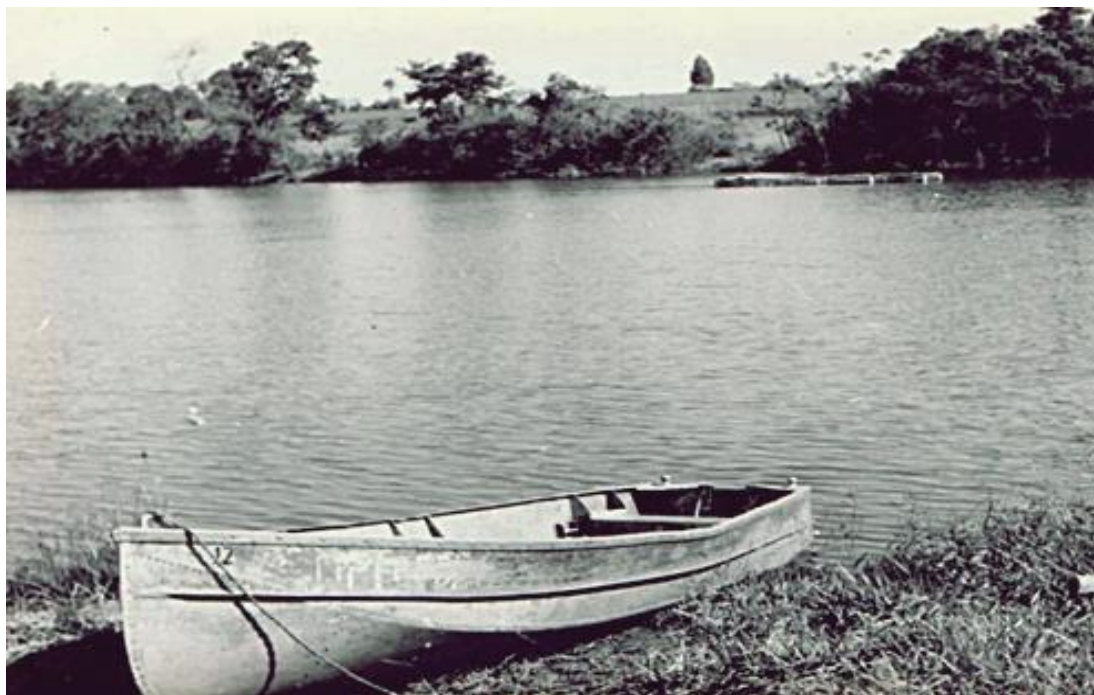
Figura 4. Vista parcial da Represa Risca Faca, Campus da USP, Fernando Costa, Pirassununga, estado de São Paulo, mostrando ao fundo os tanques-redes para engorda tilápias.
